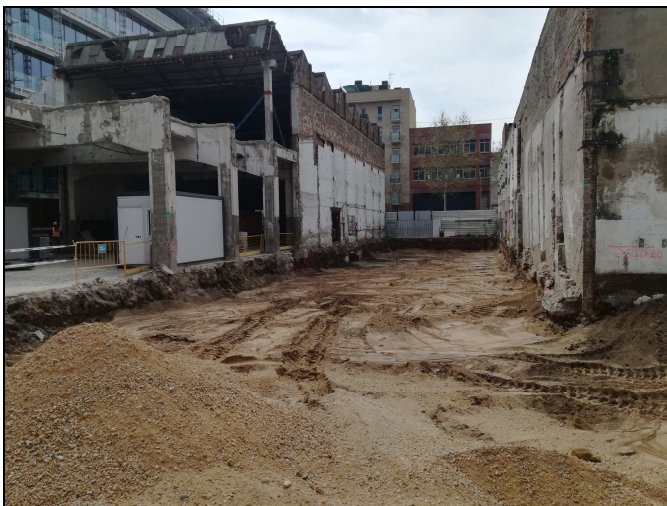
Foto 7. El solar amb el rebaix finalitzat.
